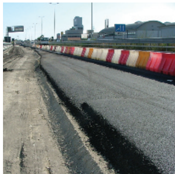
Tangenziale Nord di Padova 2005
